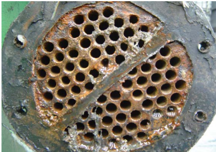
Vista 3.- Intercambiador de calor libre de incrustaciones a los 60 días de la experiencia sin uso de ningún químico.
