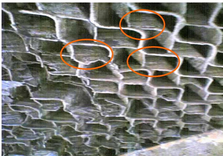
Vista 5.- Paneles internos de la torre al inicio de la experiencia con incrustaciones.
