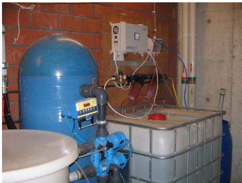
0,3% ANK iniettato con pompa dosatrice
