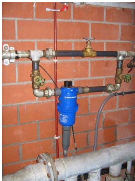
0,3% ANK iniettato con pompa dosatrice
