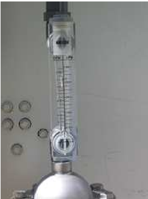
Verifica del flusso
